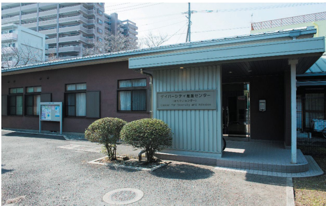
ダイバーシティ推進センター外観
