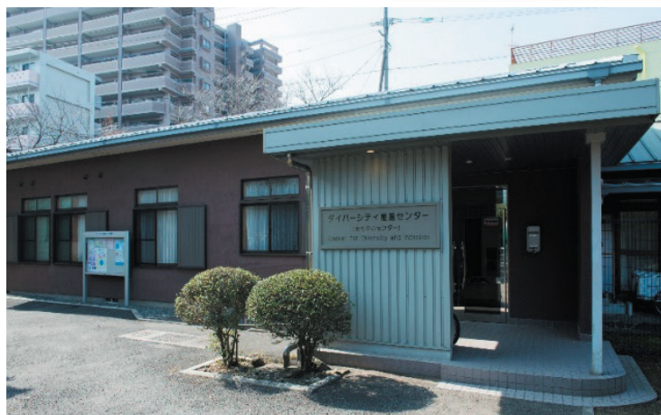
ダイバーシティ推進センター外観
